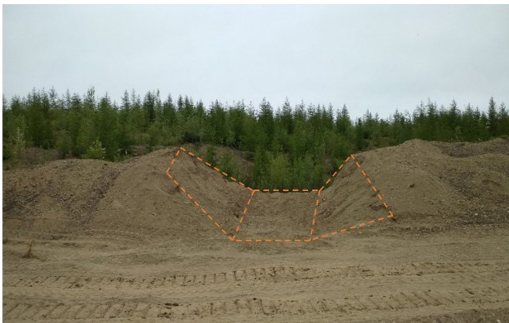
Рис. 0.14 Траншея, полученная при отборе валовой пробы бульдозером
